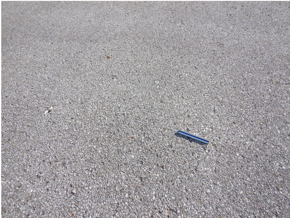
R13AL-05. Raveling (Sample Unit No. 01).
