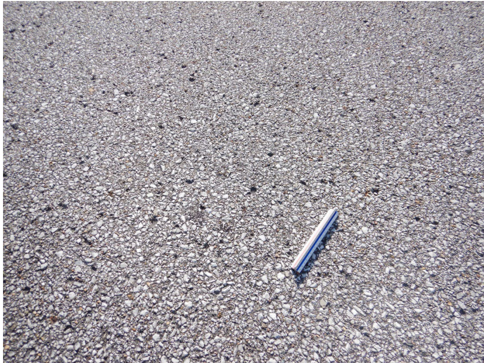
R13AL-03. Raveling (Sample Unit No. 01).
