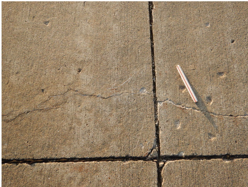
A01AN-02. ASR (Sample Unit No. 07).
