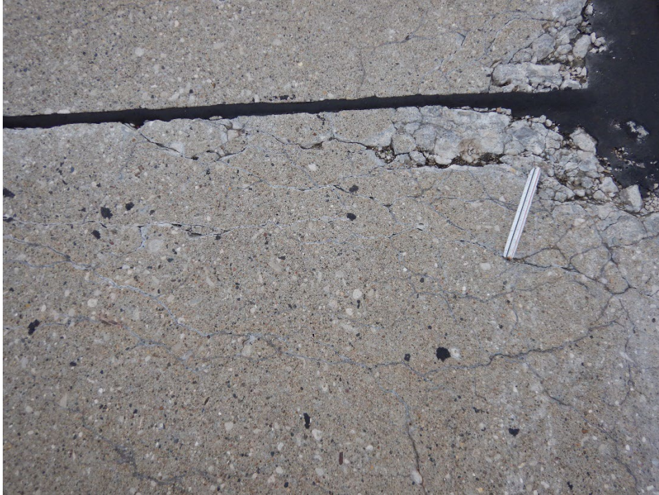
T02AN-01. ASR (Sample Unit No. 03) (3).
