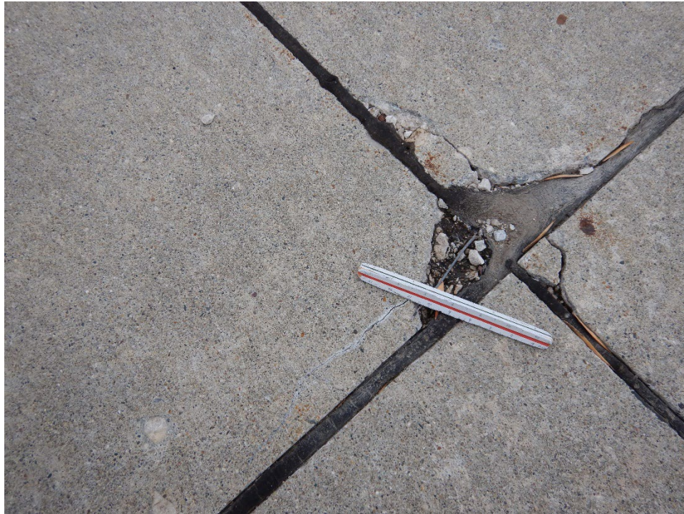
TH01AN-01. ASR (Sample Unit No. 04).
