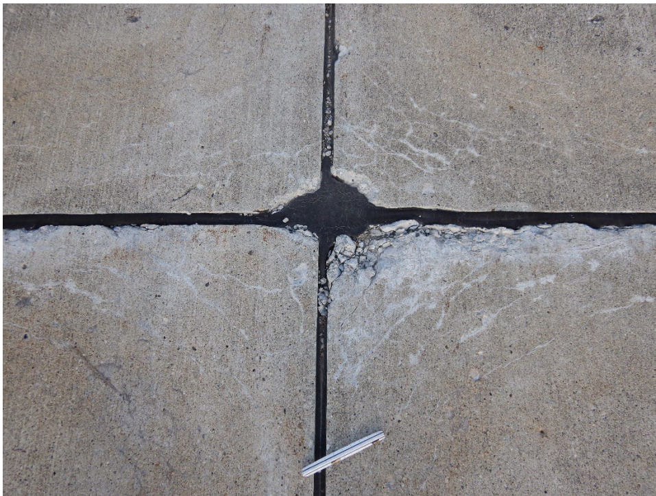
R04AN-03. ASR (Sample Unit No. 06).
