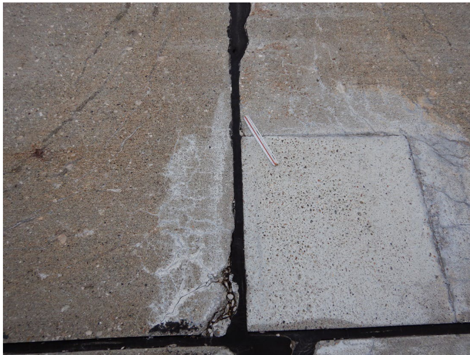
R18AN-01. ASR (Sample Unit No. 36).
