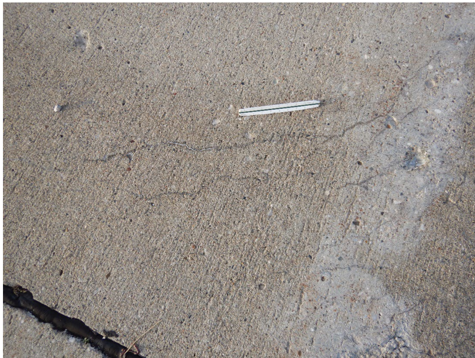
A01AN-01. ASR (Sample Unit No. 11).
