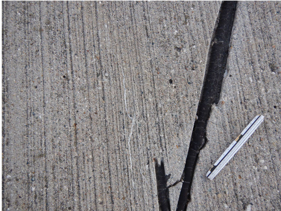
T08AN-01. ASR (Sample Unit No. 04).
