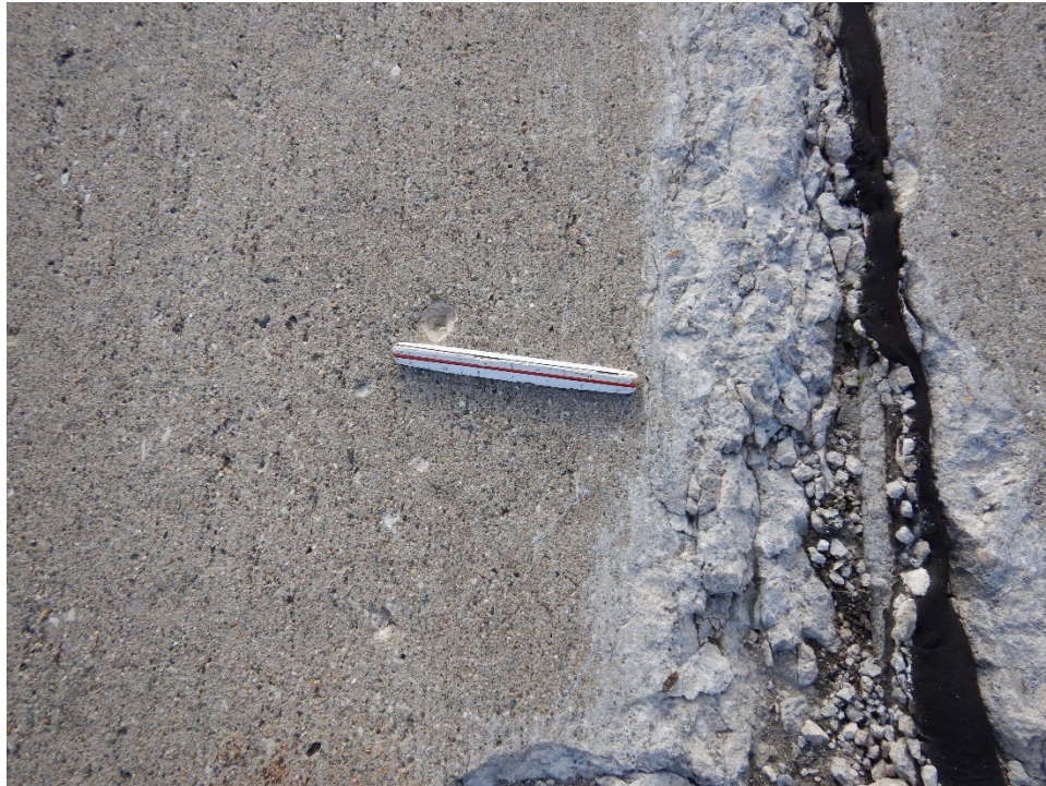
R04AN-04. ASR (Sample Unit No. 43).
