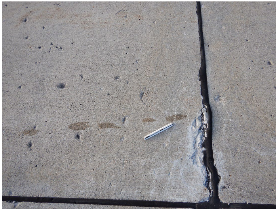
R04AN-02. ASR (Sample Unit No. 04).
