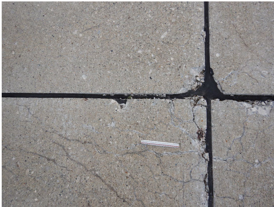
T03AN-01. ASR (Sample Unit No. 02).
