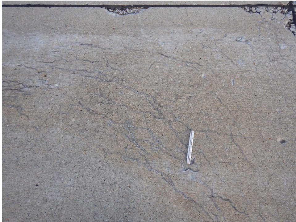
A01AN-01. ASR (Sample Unit No. 15).
