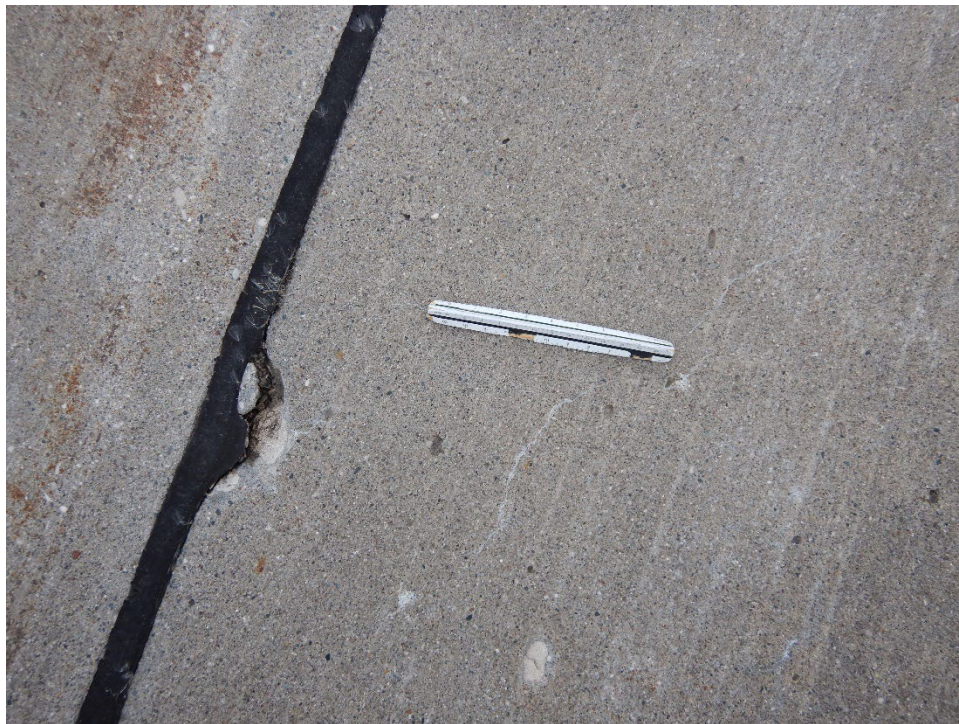
R18AN-02. ASR (Sample Unit No. 06).
