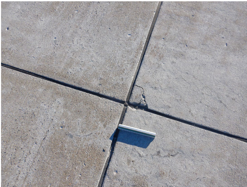
R02CD-01. ASR (Sample Unit No. 43) (1).
