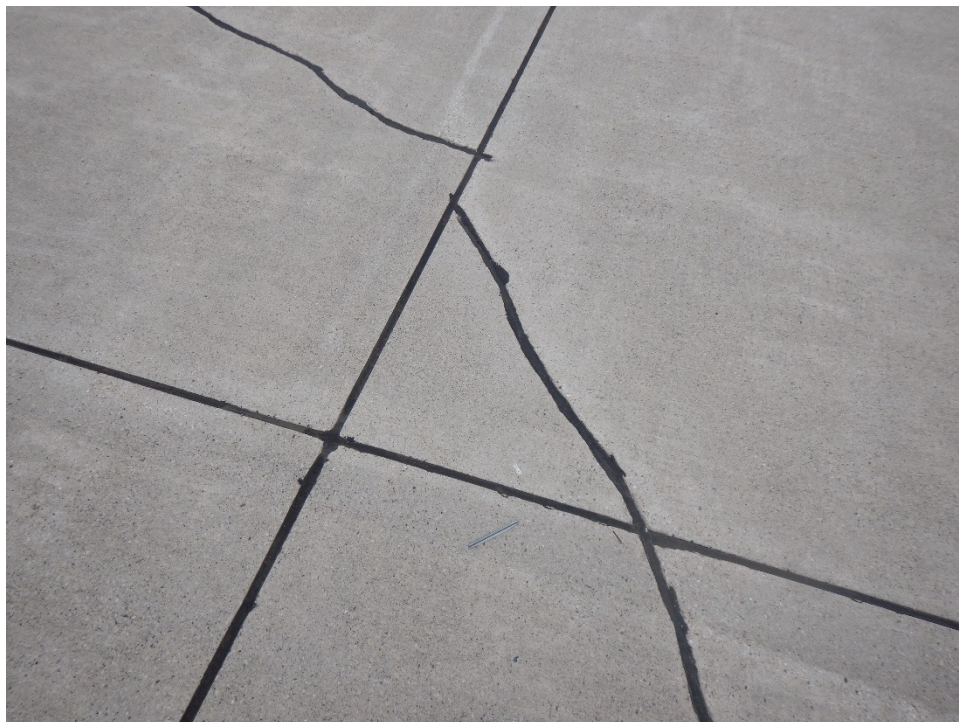
R11DE-04. Corner Break (Sample Unit No. 01).
