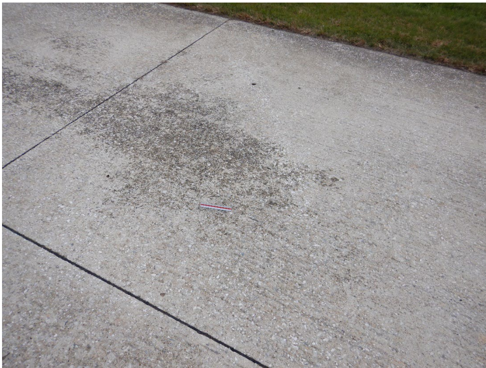
T01DN-03. Scaling (Sample Unit No. 02).
