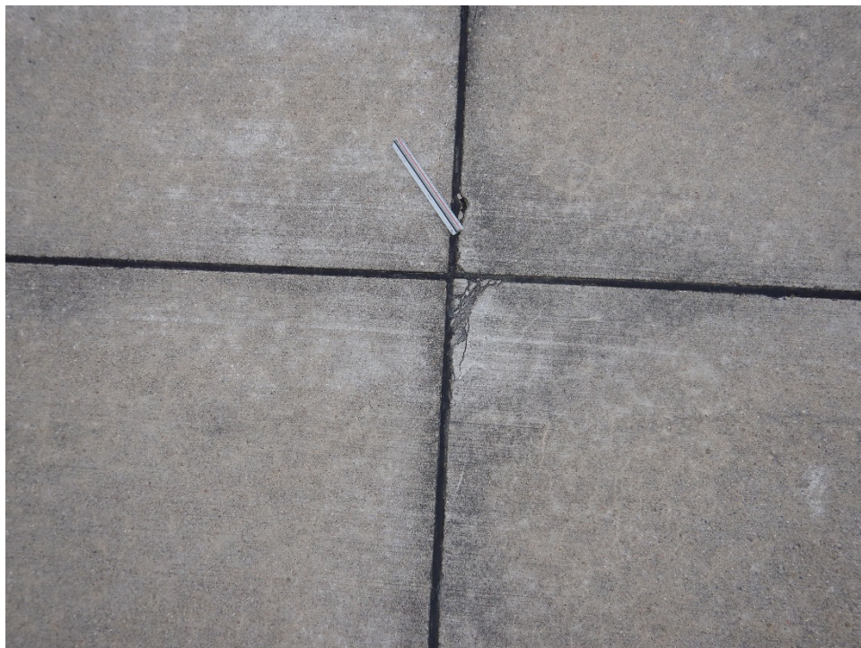
TBMU-01. ASR (Sample Unit No. 01).
