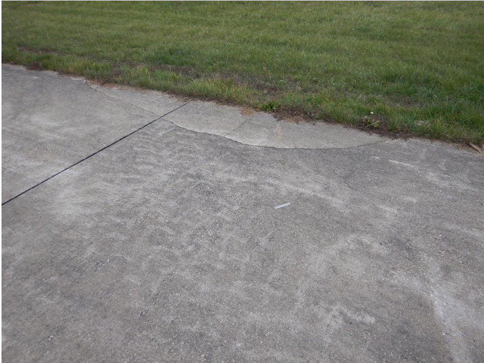
TB2MU-01. Corner Break (Sample Unit No. 02).
