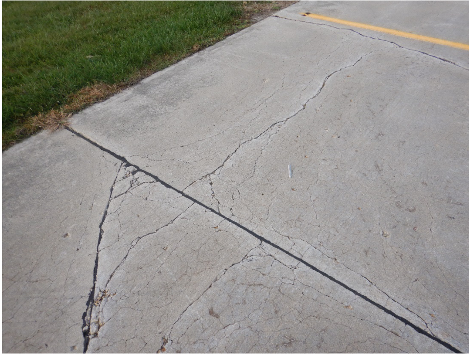
A01PR-03. ASR (Sample Unit No. 02).
