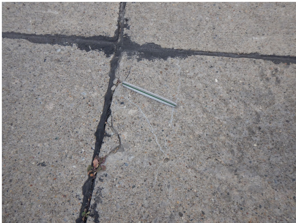
A01VI-01. ASR (Sample Unit No. 08).
