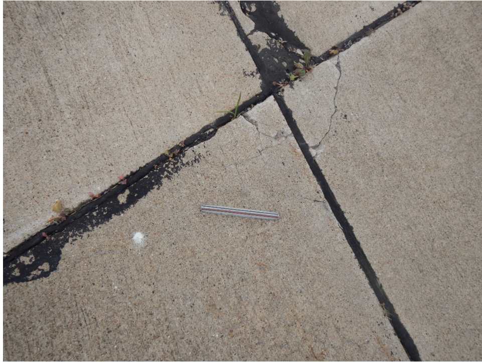
A01VI-03. ASR (Sample Unit No. 03).
