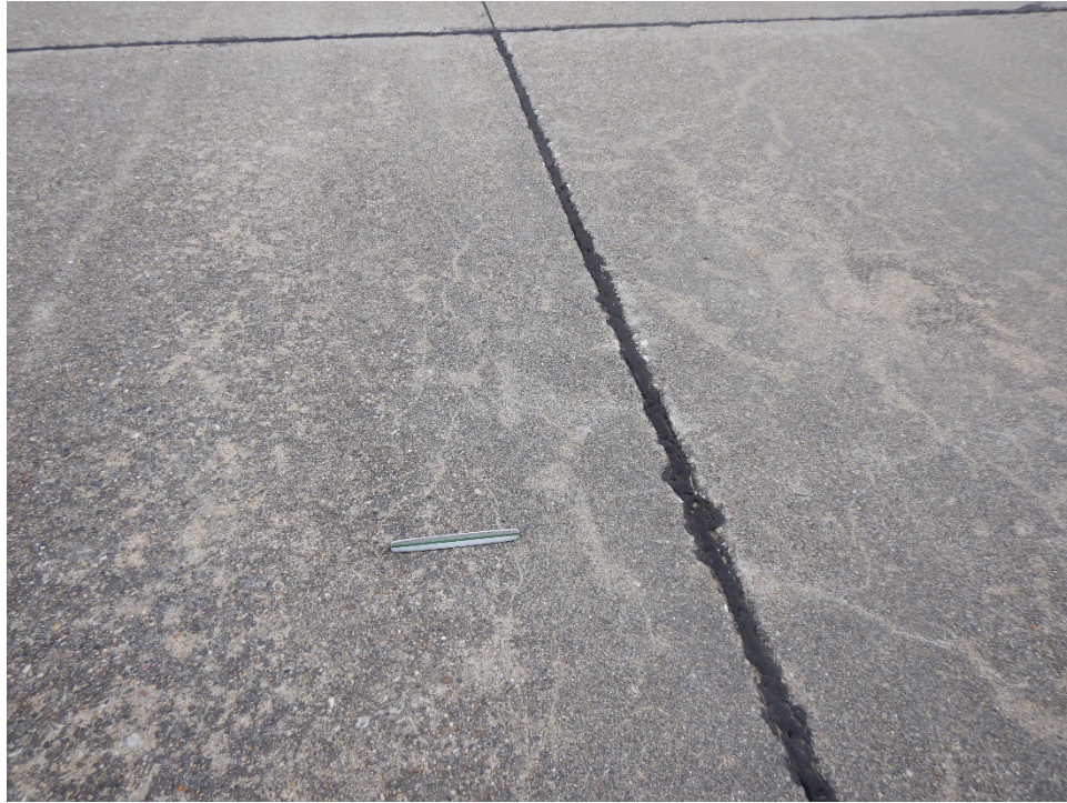
TH01VI-03. ASR (Sample Unit No. 01).
