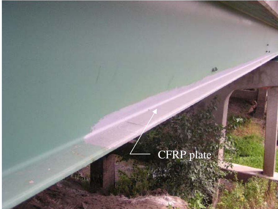
(d) Top of bottom flange of Girder 6 in the west end span
