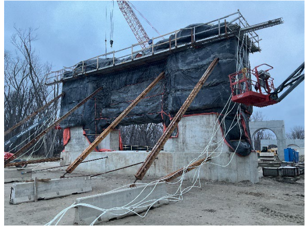
Pier 3 final pour
